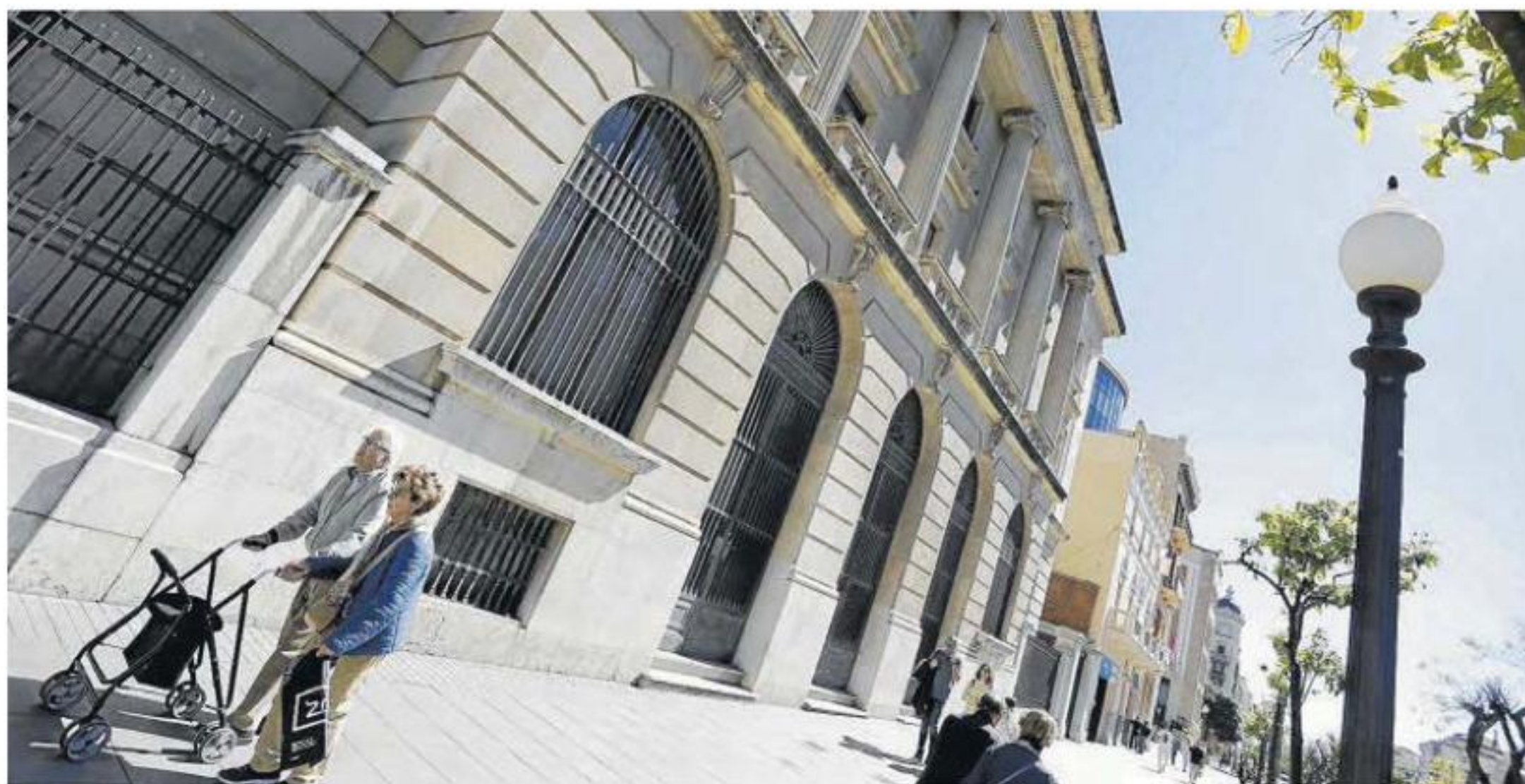
El inmueble situado en el centro de la Rambla Nova, que está cerrado y abandonado desde el año 2003. FOTO: PERE FERRÉ
