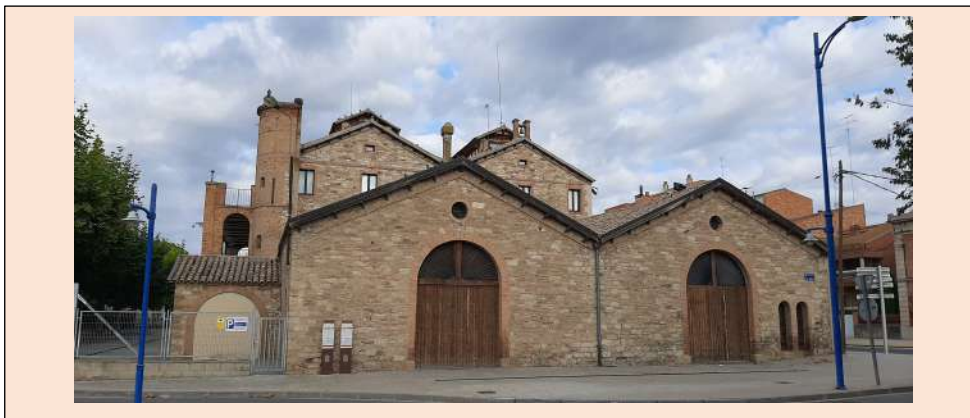
Figura 2. Casa Canal d'Urgell. Seu de la Comunitat de Regants dels Canals d'Urgell i Espai Cultural del Canal d'Urgell.
